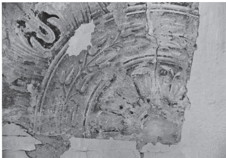
Abb. 1. Partielle Freilegung eines zentralen Deckenornamentes, hier als Imitation einer Stuckrosette, Raum 3.2.02
