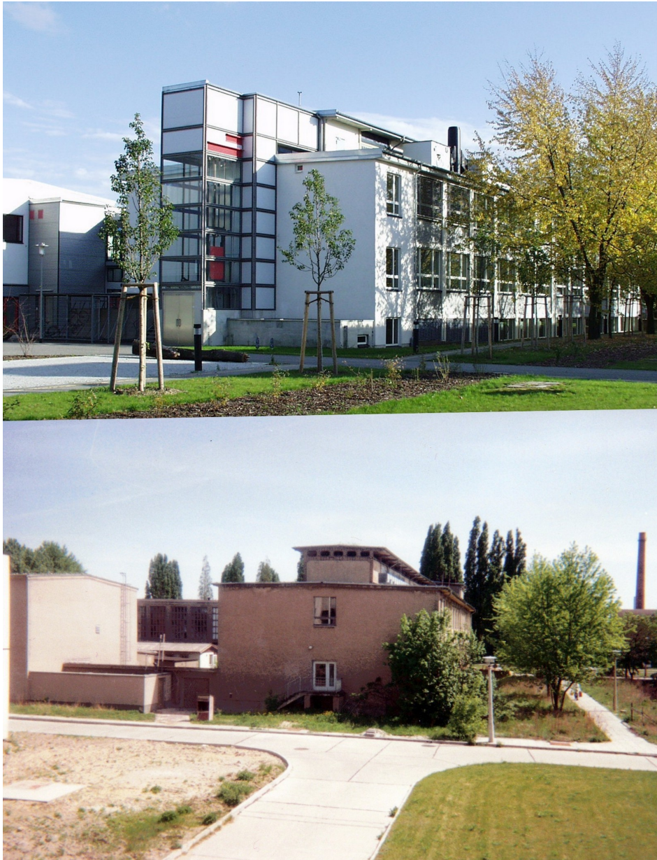
Abbildung 6.2: Bautätigkeit am MBI in Berlin-Adlershof, Gebäude Bereich B: unten im Jahr 1994 (Foto mit freundlicher Genehmigung von E. E. B. CAMPBELL), oben im Jahr 2000 (Foto IVH)
