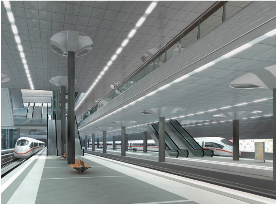
Abbildung 2 Berliner Hauptbahnhof – Lehrter Bahnhof: Realisierte Flachdeckenkonstruktion. Fotografie: gmp
