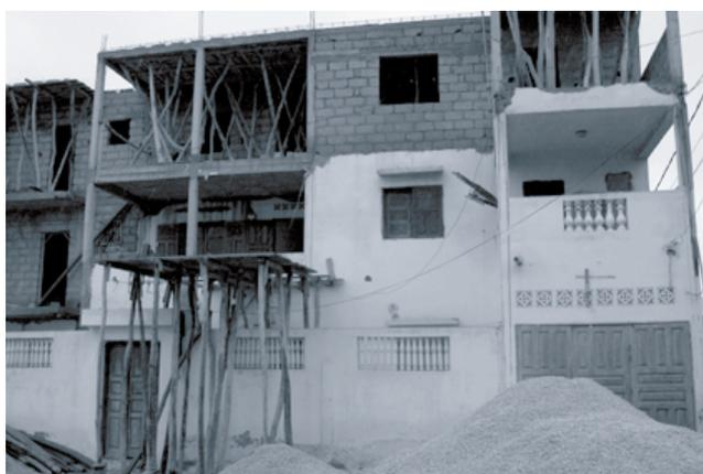
Mangel an Gerüststangen: Im Senegal werden Schalungen von Stahlbetonbauten durch Holzkonstruktionen abgestützt. Die Bauart stammt aus der Kolonialzeit.
