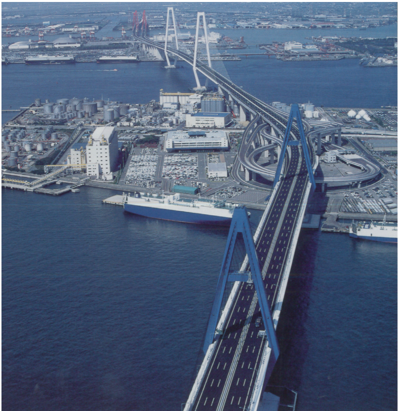
Bild 4 Hafen Nogoya (Repro aus: Journal JVBH, Int. Verein für Brücken- und Hochbau, Zürich 1996)
