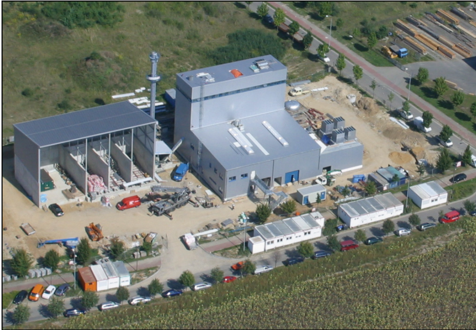
Abbildung 3 Biomasse-Heizkraftwerk Sellessen (Foto: Vattenfall Europe)
