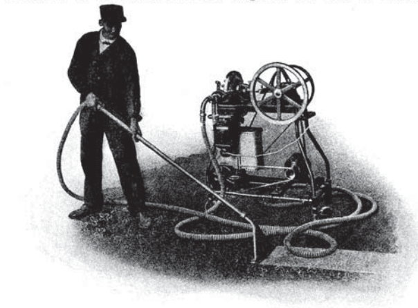
Abb. 544. Transportabler Staubsaugapparat von Hammeirath u. Co., Berlin.
