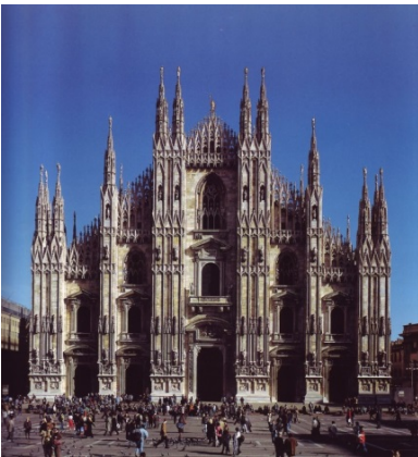
Abb. 4: Außenansicht, Westfassade, Mailänder Dom, Ende 14. Jahrhundert – 2. Hälfte 19. Jahrhundert
