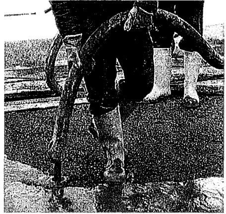
Abb. 11 SIFCON-Einbau (Philipp Holzmann AG)
