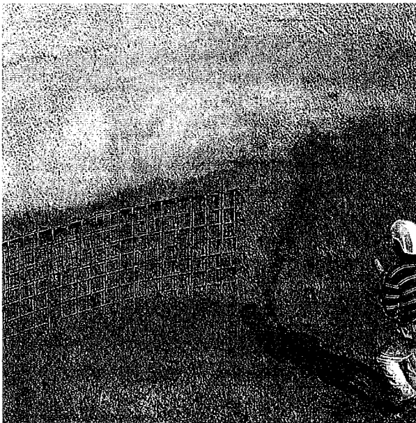
Abb. 16 \text{SiO}_2 -Naßspritzbeton
