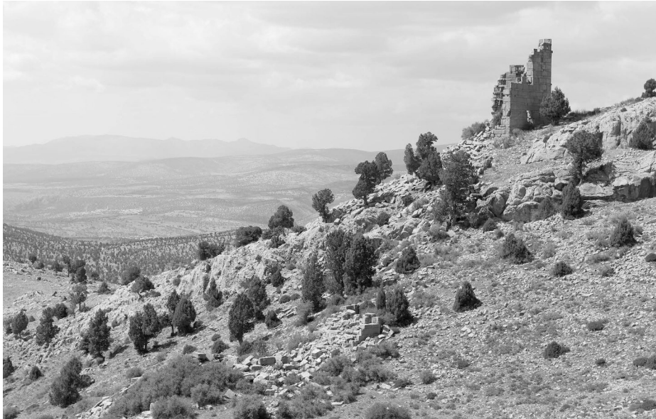
Abb. 5.12: Blick über das verfallene Stadttor von Isaura (unten mittig) in das nordwestliche Umland
