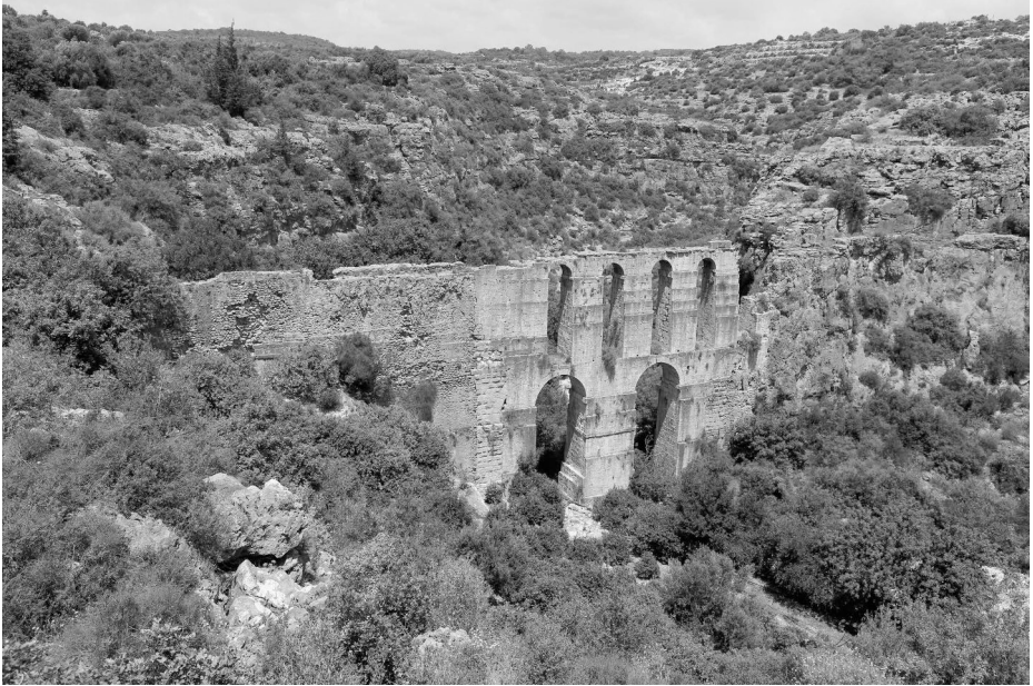
Abb. 5.7: Aquäduktbrücke I des Aquädukts aus dem Lamostal nach Sebaste und Korykos
