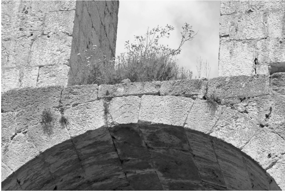
Abb. 5.8: Detail der Aquäduktbrücke I: Tatzenkreuz am nördlichen Bogen
