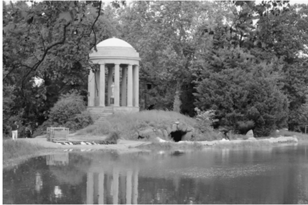
1 Deichverteidigungsmaßnahmen am Venustempel während des Sommerhochwassers 2013.
