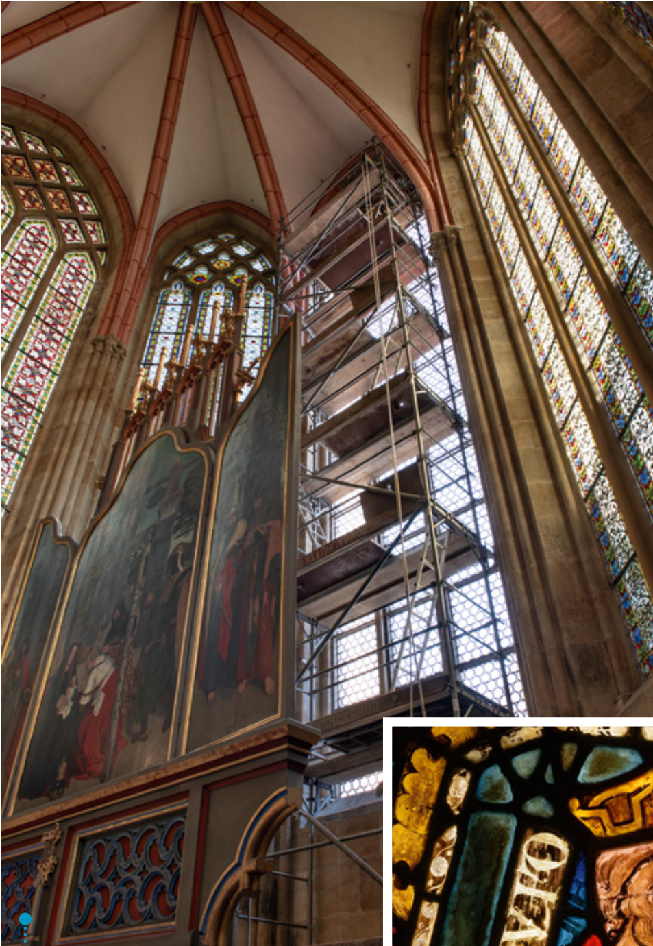
Meißen, Dom, Gerüststellung vor dem Chorachsenfenster
