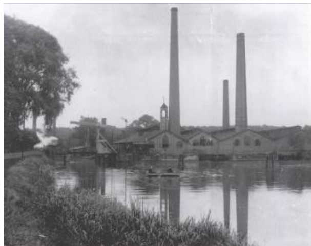
Die Ansicht vom Nordufer des Finowkanals zeigt die große Halle des Walzwerks (Foto um 1912)
