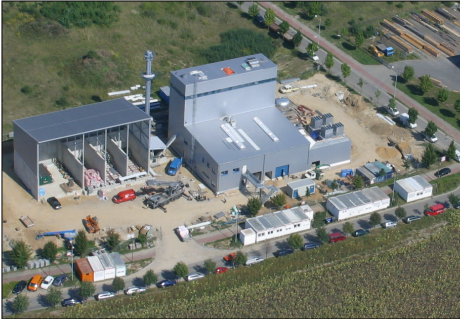
Abbildung 3 Biomasse-Heizkraftwerk Sellessen (Foto: Vattenfall Europe)
